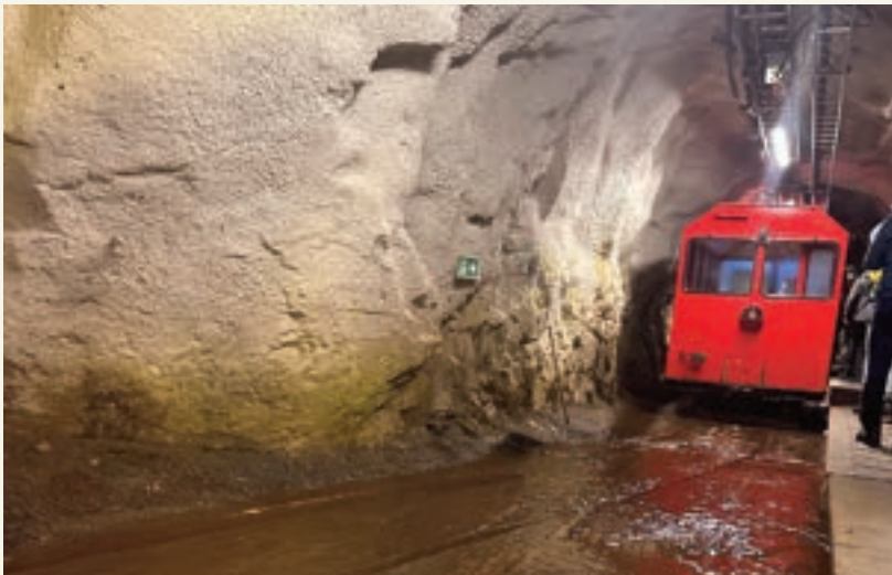
Inne i fjellet, på vei opp til Gaustadtoppen. Vannet flyter i skinnegangen.
