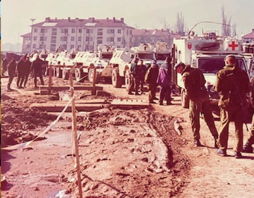
Kolonnen av SISU-er er ankommet Gorazde. Foto:
