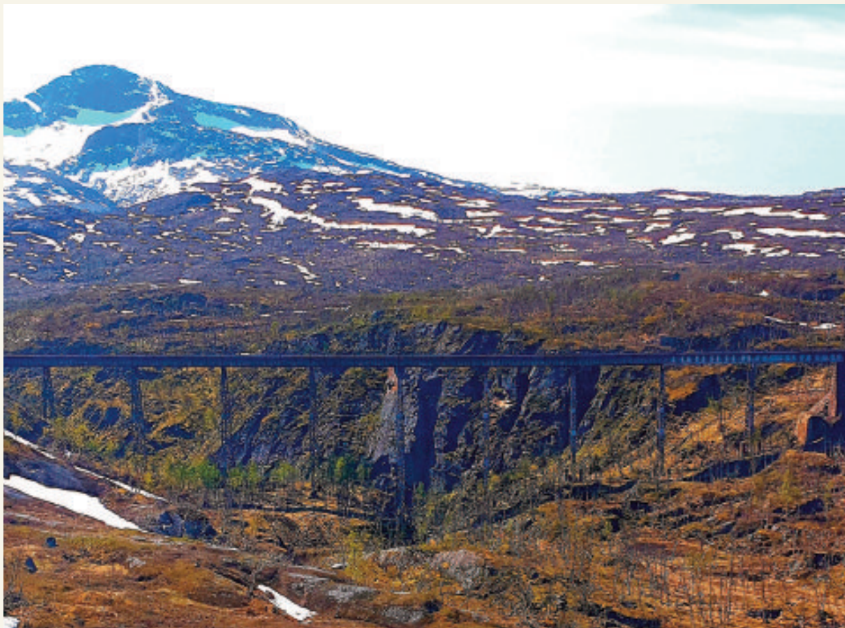
The Bridge", Norddalsbrua som sto ferdig august 1902 etter fem måneders konstruksjonsarbeid. 170 meter lang og 40 meter høy. Ikke så lett å sprengre som opprinnelig tenkt, viste det seg i 1940.
